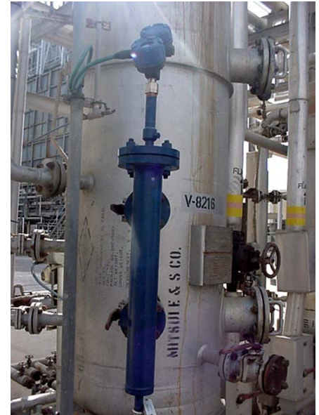
Kuva: Eclipse-sauvatutka mittauskammioineen. Kiteytymisriskin vuoksi anturin tyvessä on lisävarusteena pursotusyhde.
