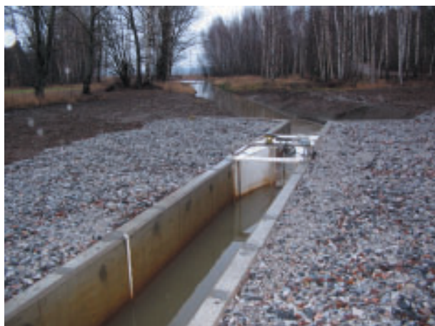
Kuva 1 Porvoon jalostamon sadevesivirtausmittaus Avokanava "Parshall-flume" tyyppi P7, maks 20000 m 3 /h
